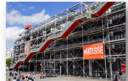
Das Centre Pompidou Paris der Architekten Renzo Piano, Richard Rogers und Gianfranco Franchini wird 1977 eröffnet.
